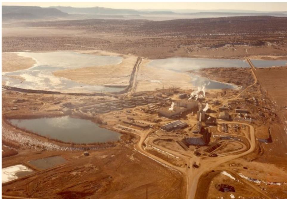
Abbildung: Lagerung von Abfallstoffen des Uranbergbaus in New Mexico (USA)
